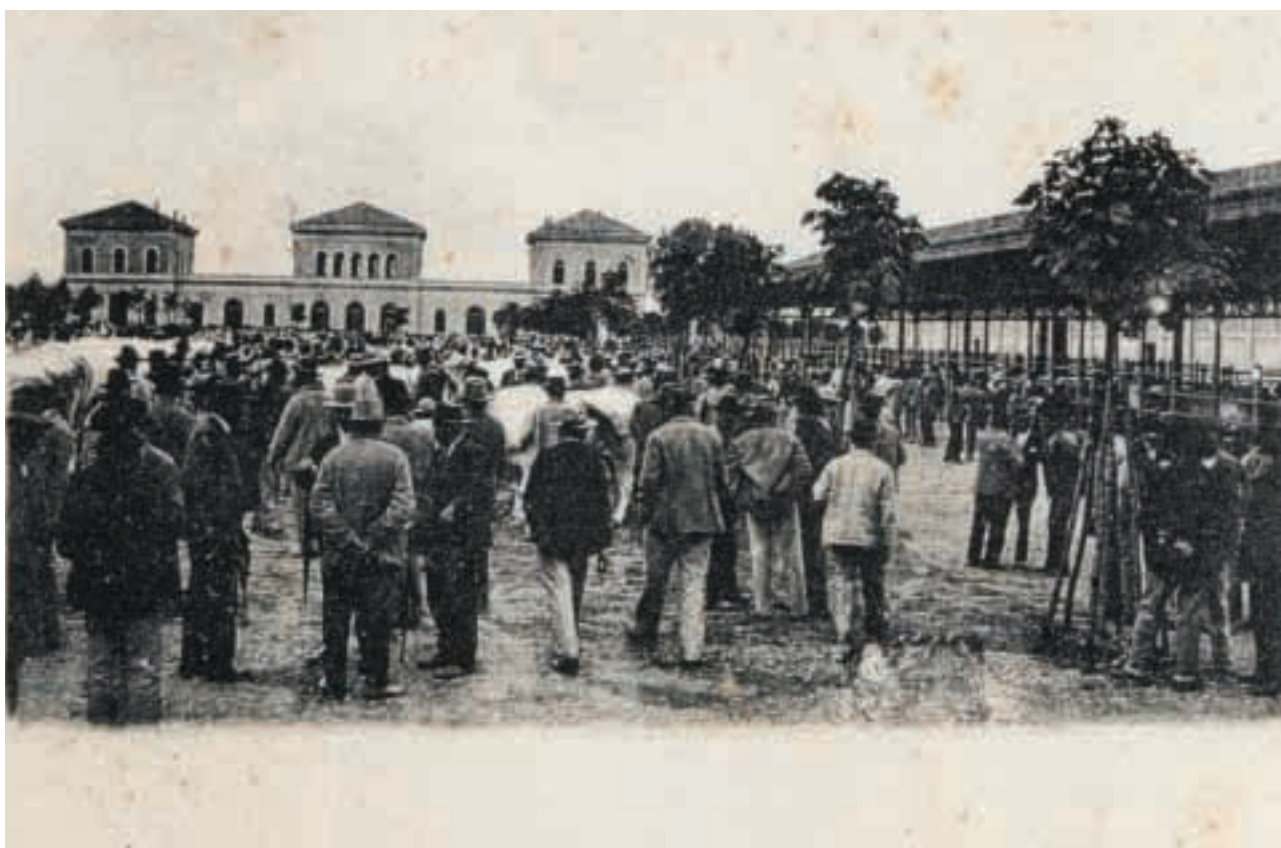
Bologna, fine dell'Ottocento. Il Mercato del Bestiame. Sullo sfondo l'ingresso monumentale con le palazzine dei servizi e a destra la tettoia per la vendita dei bovini.
